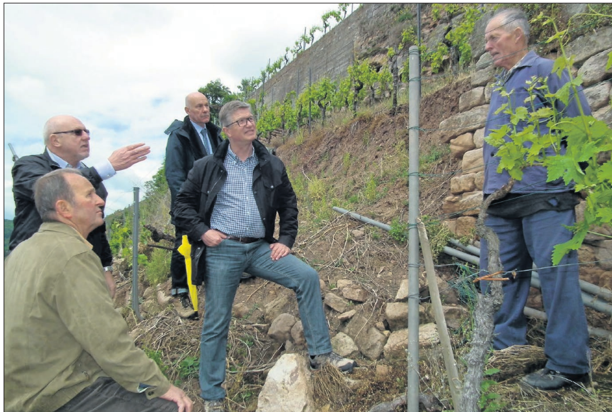
Hier heißt es anpacken: Otto Rapp, Claus Hägele, Roland Bauer, Landrat Heinz Einingler und Adolf Fingerle (von links) vor einer eingestürzten, vormals zwei Meter hohen Trockenmauer. Foto: Eisenhardt
