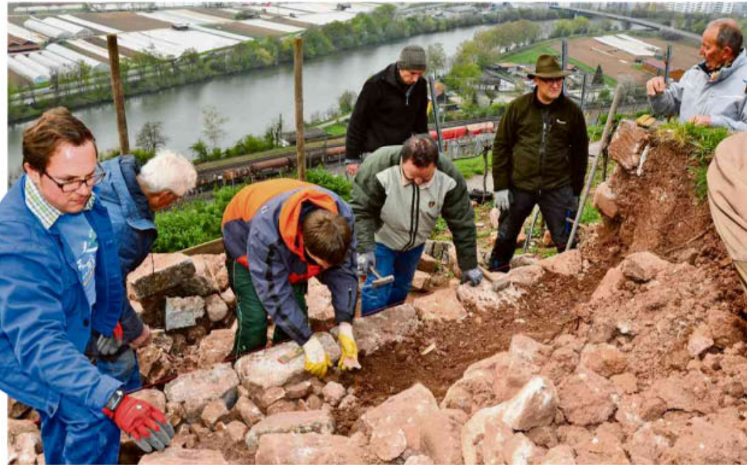
Stein um Stein wird eine Trockenmauer nach historischem Vorbild gesetzt. Foto: Koch
