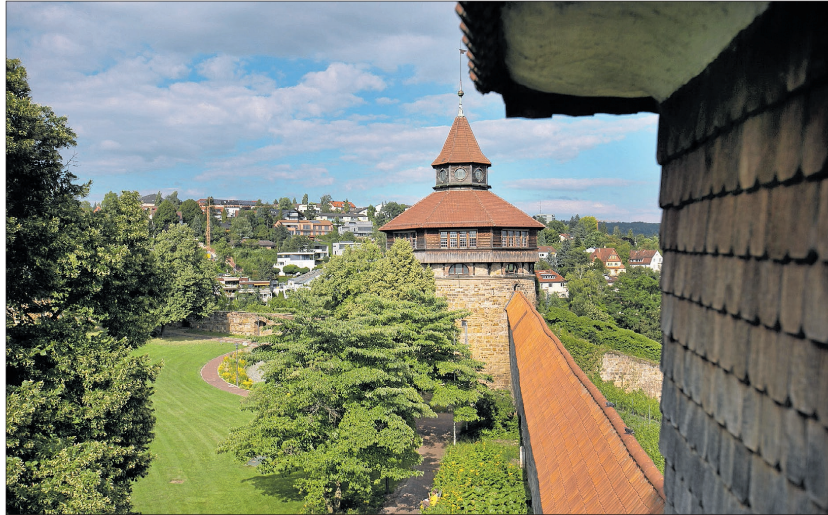
Der Dicke Turm wartet seit Jahren auf seine Sanierung. Nun will die Stadt das Projekt gemeinsam mit Turmwächtern und Burgverein anpacken. Fotos: Bulgrin
